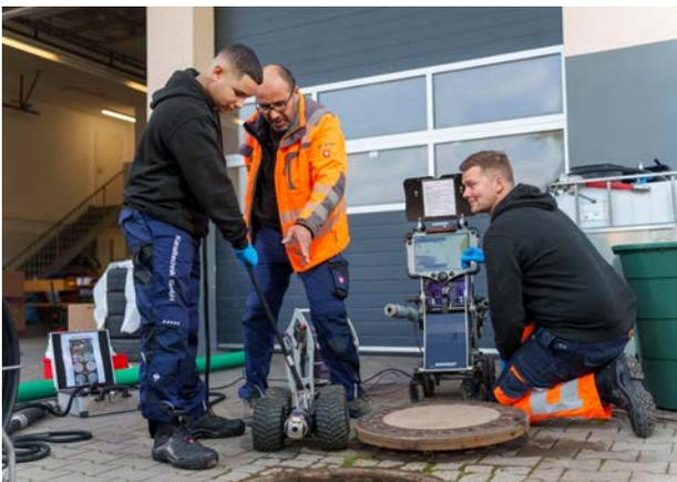
Abbildung 8: Schachtinspektion mit Inspektionskamera (Quelle: VDRK)
