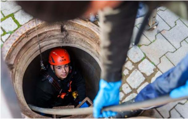
Abbildung 4: Tragen der Persönlichen Schutzausrüstung (Quelle: VDRK)
